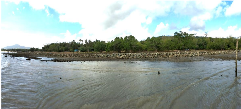
Figure 6. The 108-m permeable living breakwater in Bacjawan Norte.
